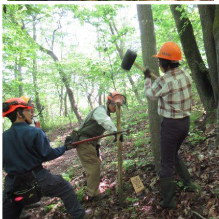
支障木の撤去
