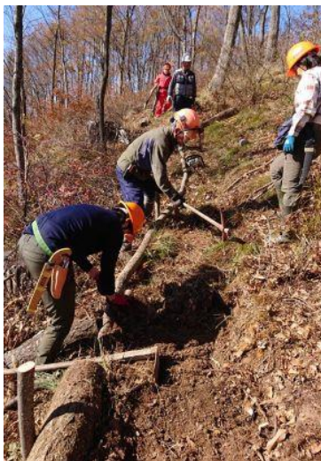
土止め用の材を入れて土をならす
