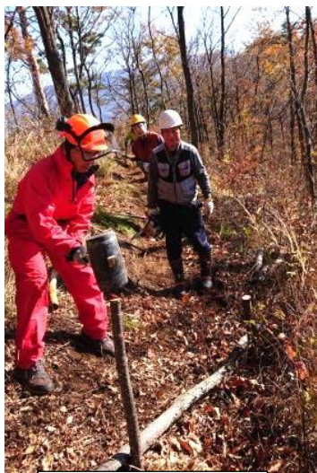
土止め用の杭打ち
