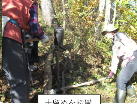
土留めを設置
